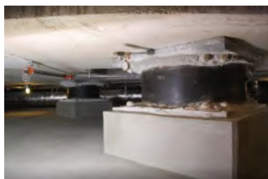
Рис. 1. Устройство для замедления вибрации сооружений
