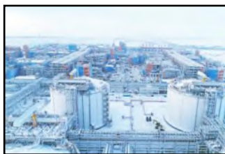
Рис.1 . Завод СПГ, объект «ЯМАЛ СПГ»
