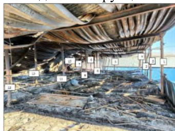
Рис. 1. Вид металлических конструкций
