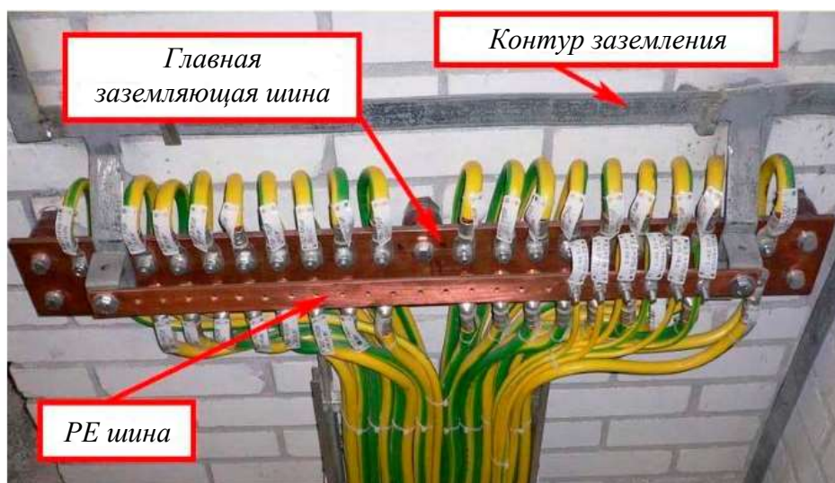
Рисунок 63 – Главная заземляющая шина (внешний вид)
