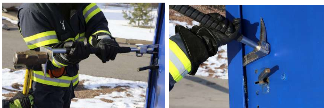
Рисунок 254 – Приемы вскрытия дверей, открывающихся внутрь
