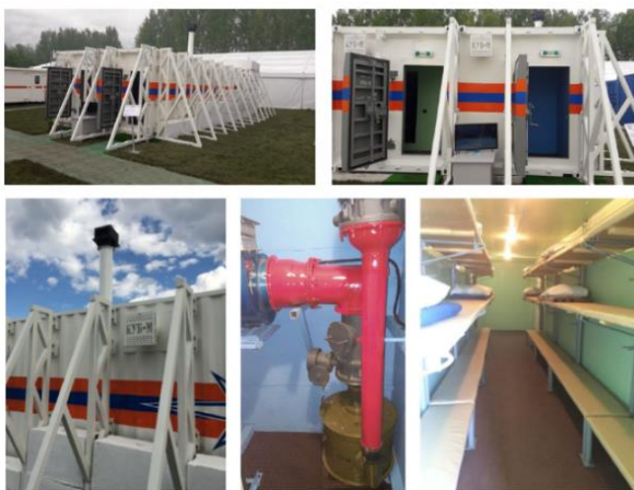
Рисунок 5.4.3 – Пример защитного сооружения блок-модульного типа
