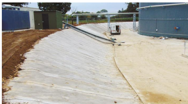
Рис. 7.3.5 – Обвалование резервуарного парка
