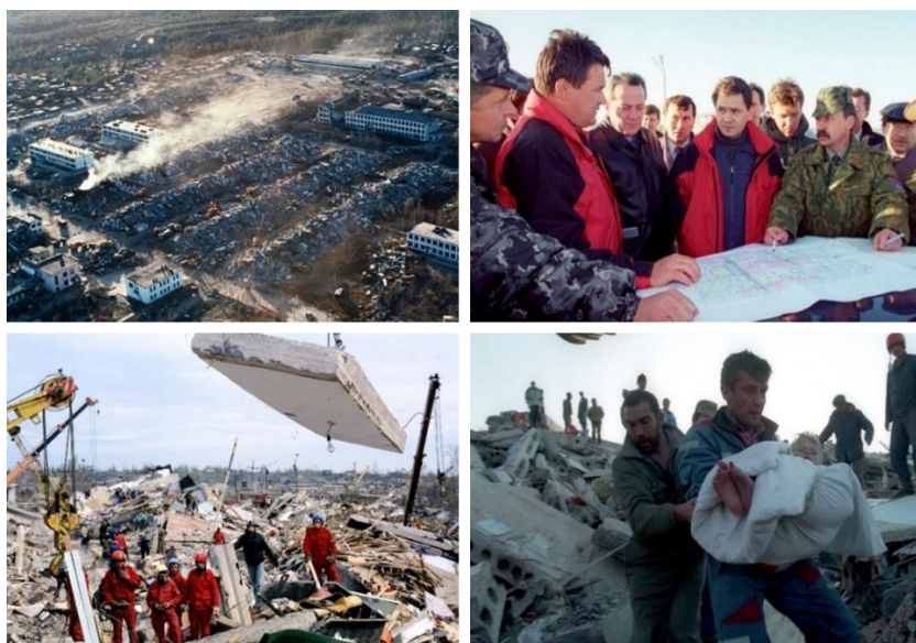
Рис. 1.1.3.3 – Ликвидация последствий землетрясения в н.п. Нефтегорск Сахалинской области (1995 г.) [55]
