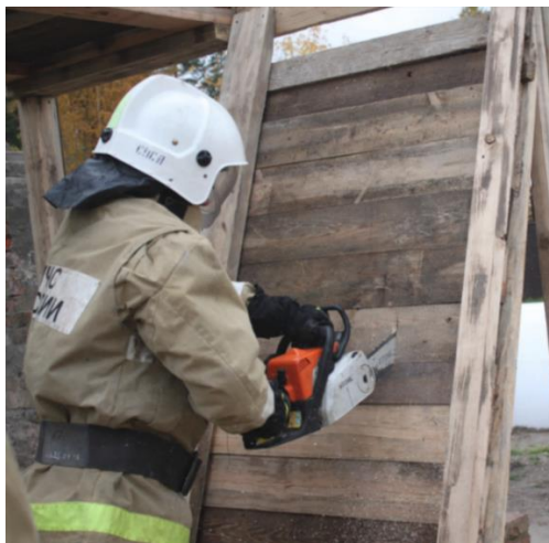
Рис. 5.6.7 – Работа на модуле «упавшая стена» с использованием механизированного инструмента
