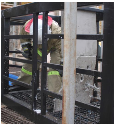
Рис. 5.6.11 – Пробивание бетонной стены с использованием немеханизированного инструмента
