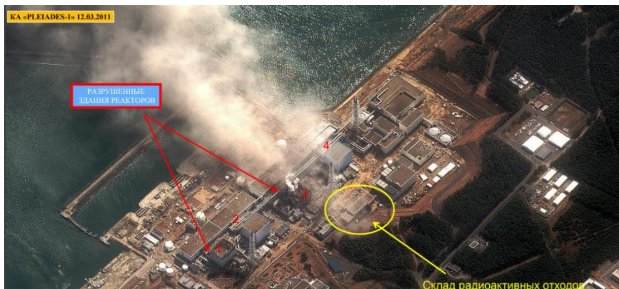
Рис. 1.1.5.3 – Космический снимок разрушений на японской АЭС «Фукусима-1» в результате землетрясения и цунами в 2011 году [60]
