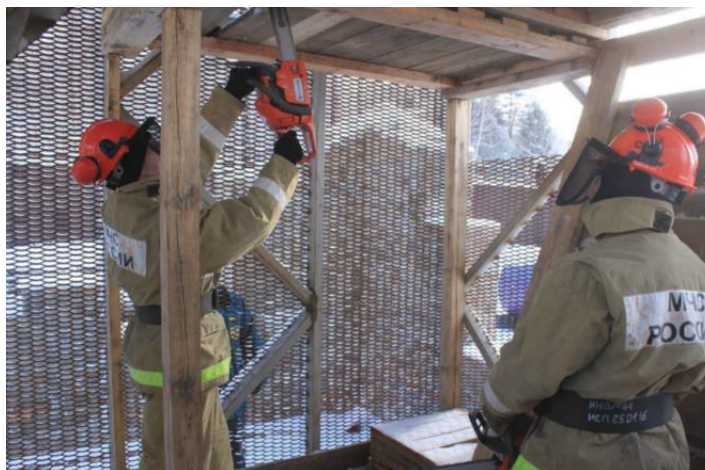
Рис. 5.6.5 – Вскрытие подшивки потолка
