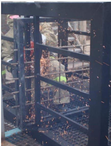
Рис. 5.6.10 – Резка арматурной клетки
