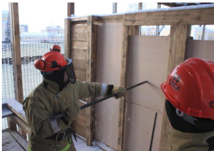
Рис. 5.6.6 – Вскрытие пустотелых перегородок с использованием немеханизированного инструмента
