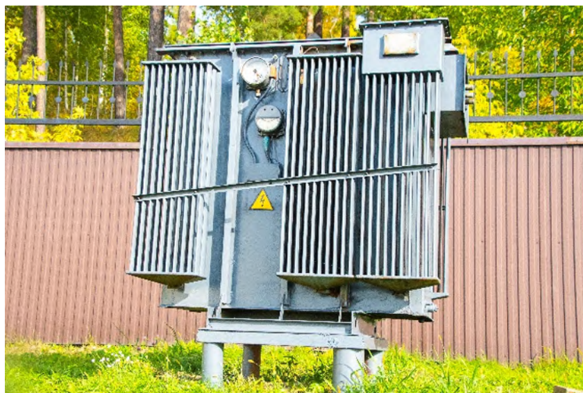
Рисунок 29 – Электротрансформатор
