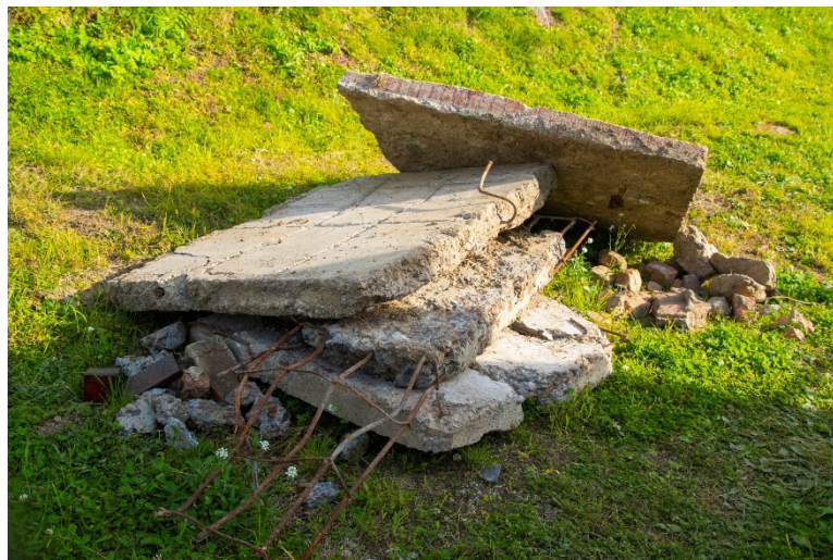
Рисунок 42 - Деревянные и бетонные завалы
