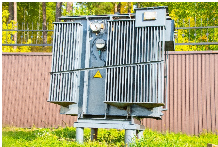
Рисунок 30 – Электротрансформатор
