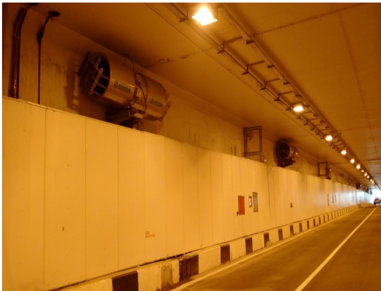
Рис. 5. Установка струйных вентиляторов в Алабяно-Балтийском автодорожном тоннеле г. Москвы
