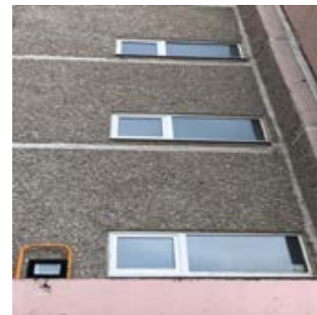
Рис. 1. Пример оконных проемов лестничных клеток с комбинированным способом остекления в многоэтажных зданиях старой постройки (с фрамугой и глухим остеклением)
