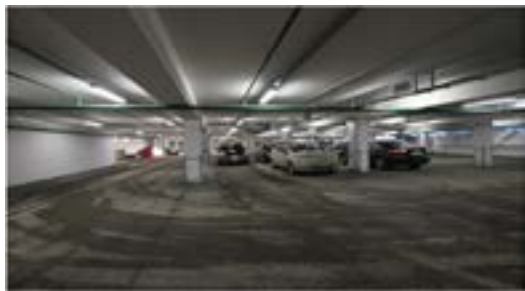
Рис 1. Парковка подземная в торговом центре
