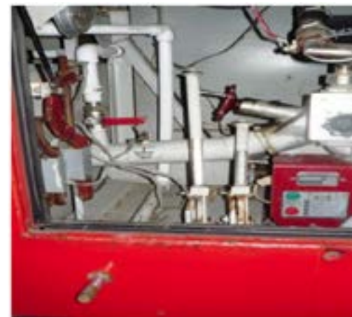
Рис. 5. Вывод выходного пластикового трубопровода со штуцером от мотопомпы для присоединения армированного шланга
