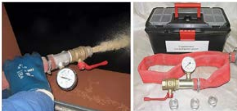
Рис.5. Испытание пожарных кранов на водоотдачу
