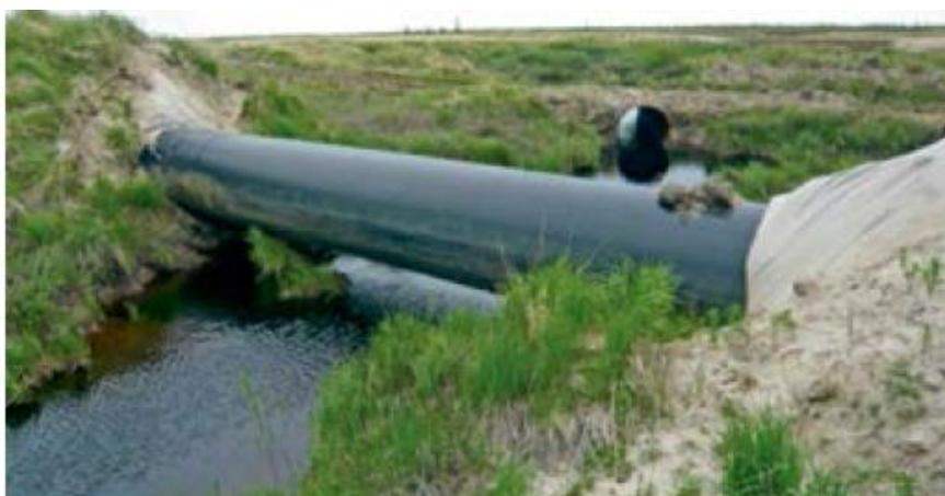
*Рис. 4. Образование провала и оголение подземного участка трубопровода*
