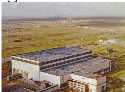
Рис. Сооружение 1 МИК площадки №254 космодрома Байконур
