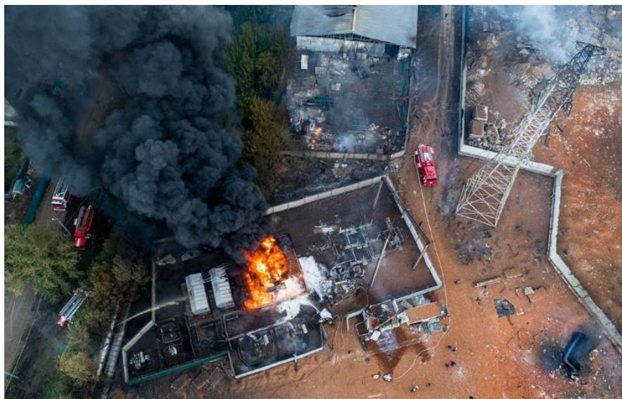
Рис.2. Последствия разрушения газопровода 27 ПАО «Мосэнерго»
