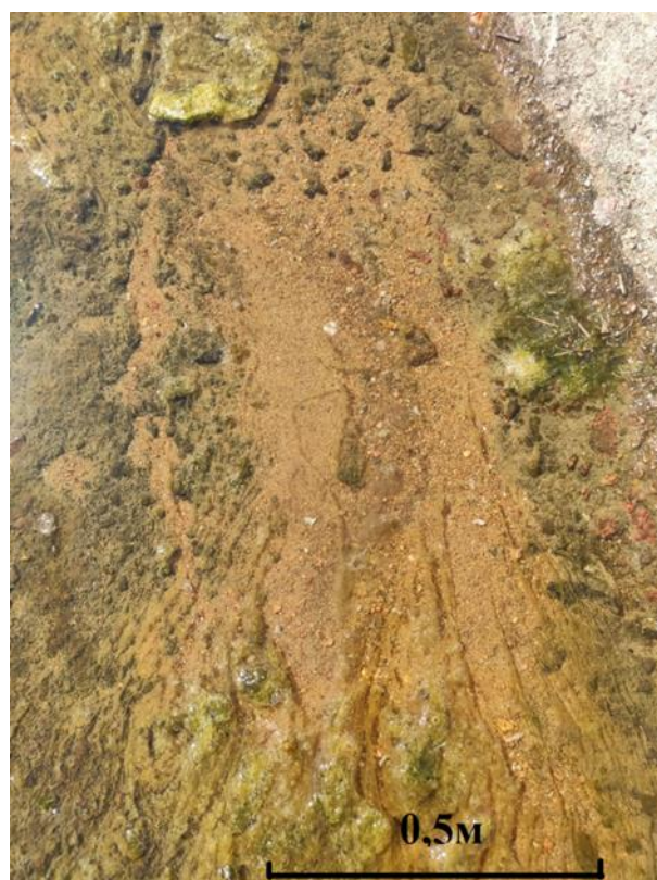
Рис. 5. Зона выноса песчаного, разнородного, полиминерального материала из 2-го грифона в нижнем бьефе тела дамбы.
