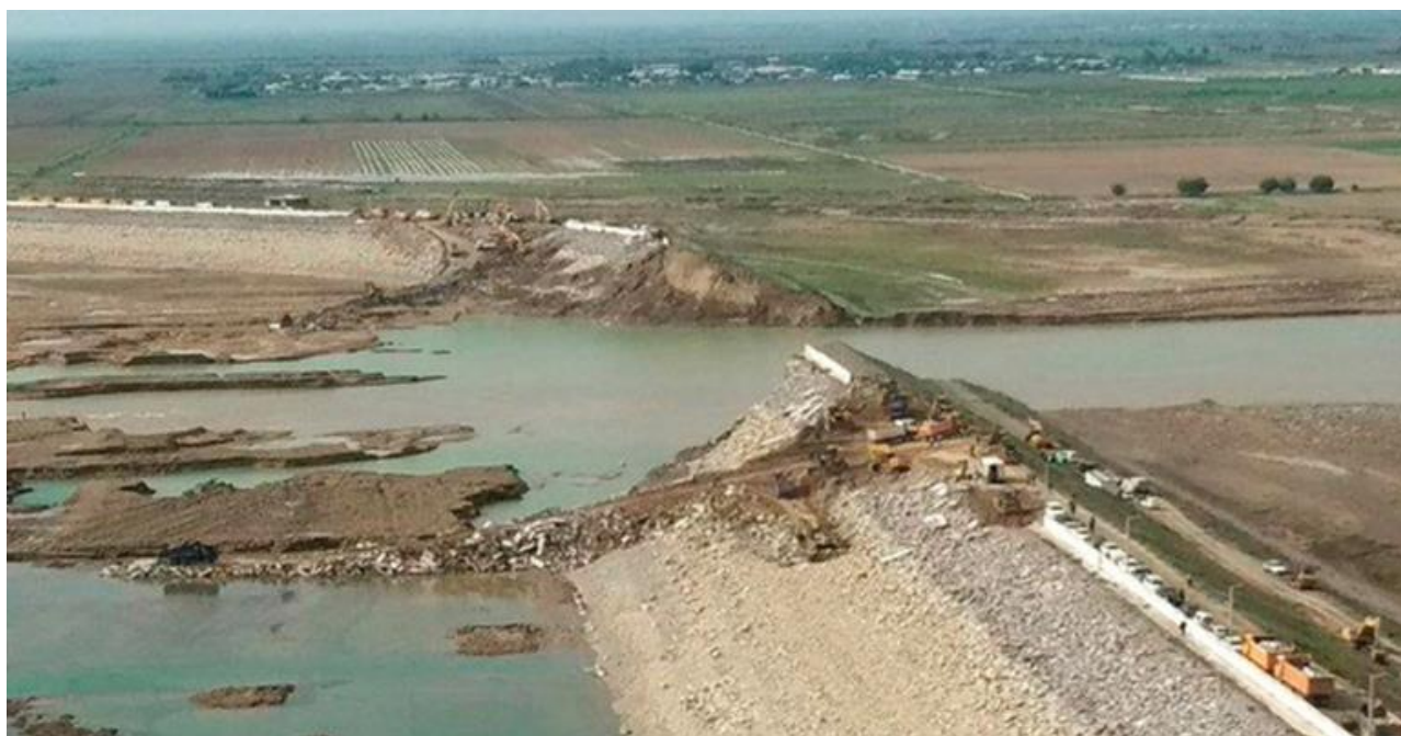
Рис. 3. Разрыв дамбы Сардобинского водохранилища в районе 6-го пикета. Вид со стороны нижнего бьефа. Фото по ссылке https://fergana.media/news/122054/
